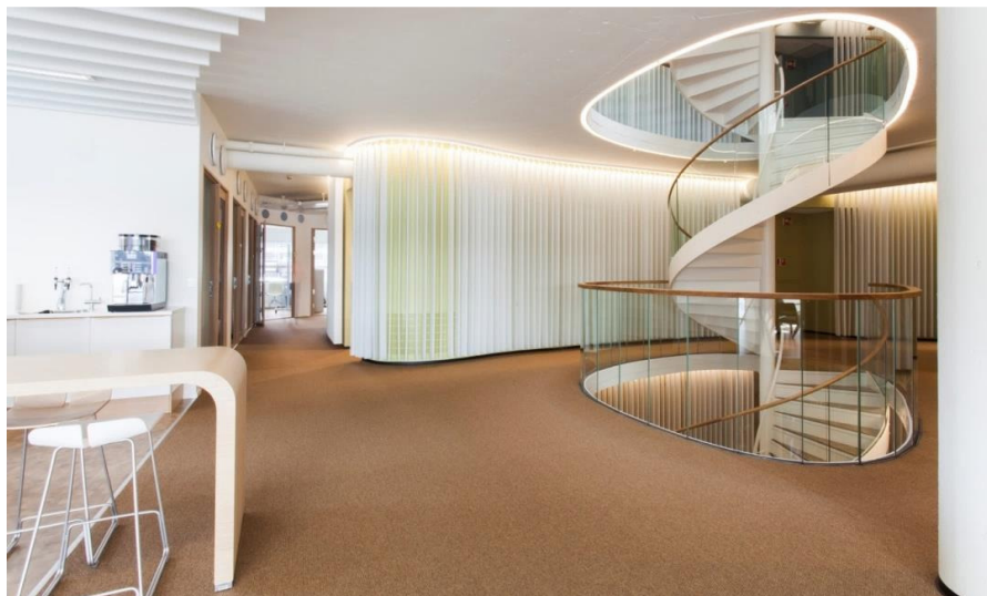
Figur 9.4. Illustrasjon på hvordan materialbruken til ventilasjonskanaler er drastisk redusert i ZEB-pilotbygg Powerhouse Kjørbo: Systemhimlingen er fjernet, og selve rommet og trappeløpet er blitt «ventilasjonskanal». Foto: Chris Aadland, Arkitekt: Snøhetta.
